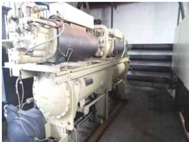
中信戴卡東部廠區採暖餘熱改造現場
