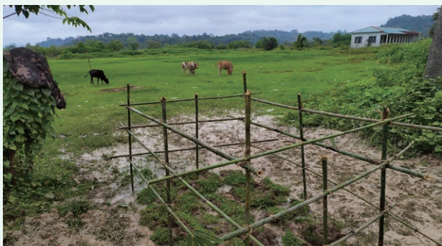
中信建设对陆域探坑进行生态修复
