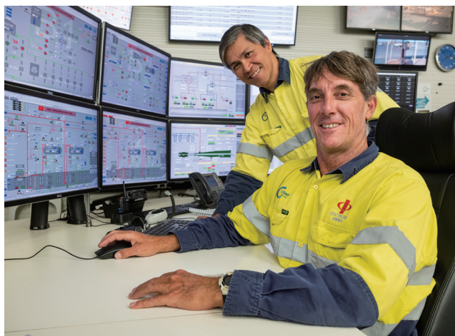
— 中信澳礦發電站控制室
