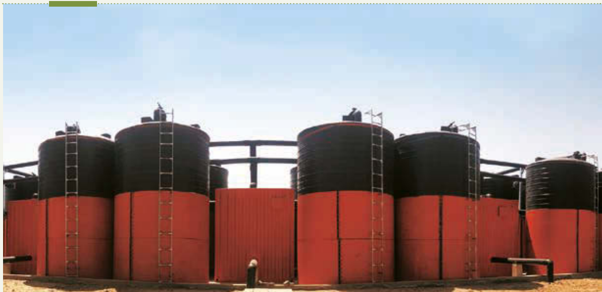
■ 中信環境技術辛集污水處理廠
