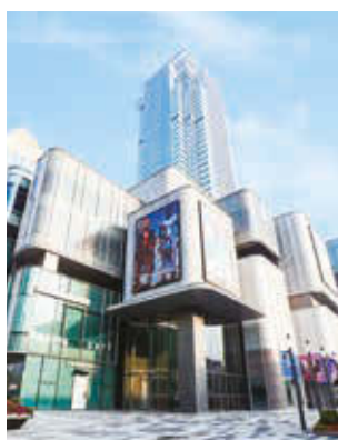
上海中信泰富廣場
