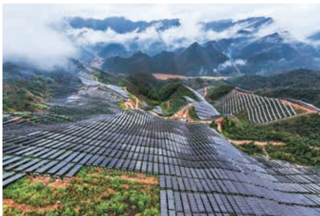
浙江桐廬農光互補光伏項目
