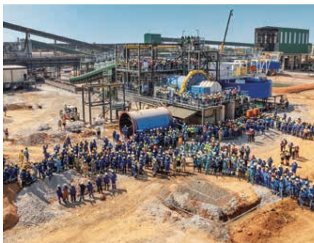
剛果(金)基普什鋅礦SMPP供貨與安裝工程項目
