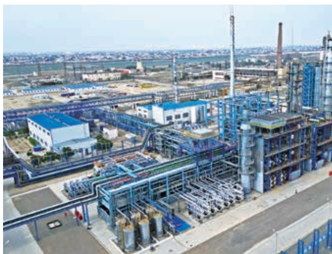
哈薩克斯坦瀝青廠改造項目竣工投產
