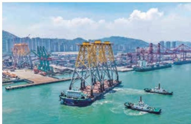
海上風電項目導管架發運
