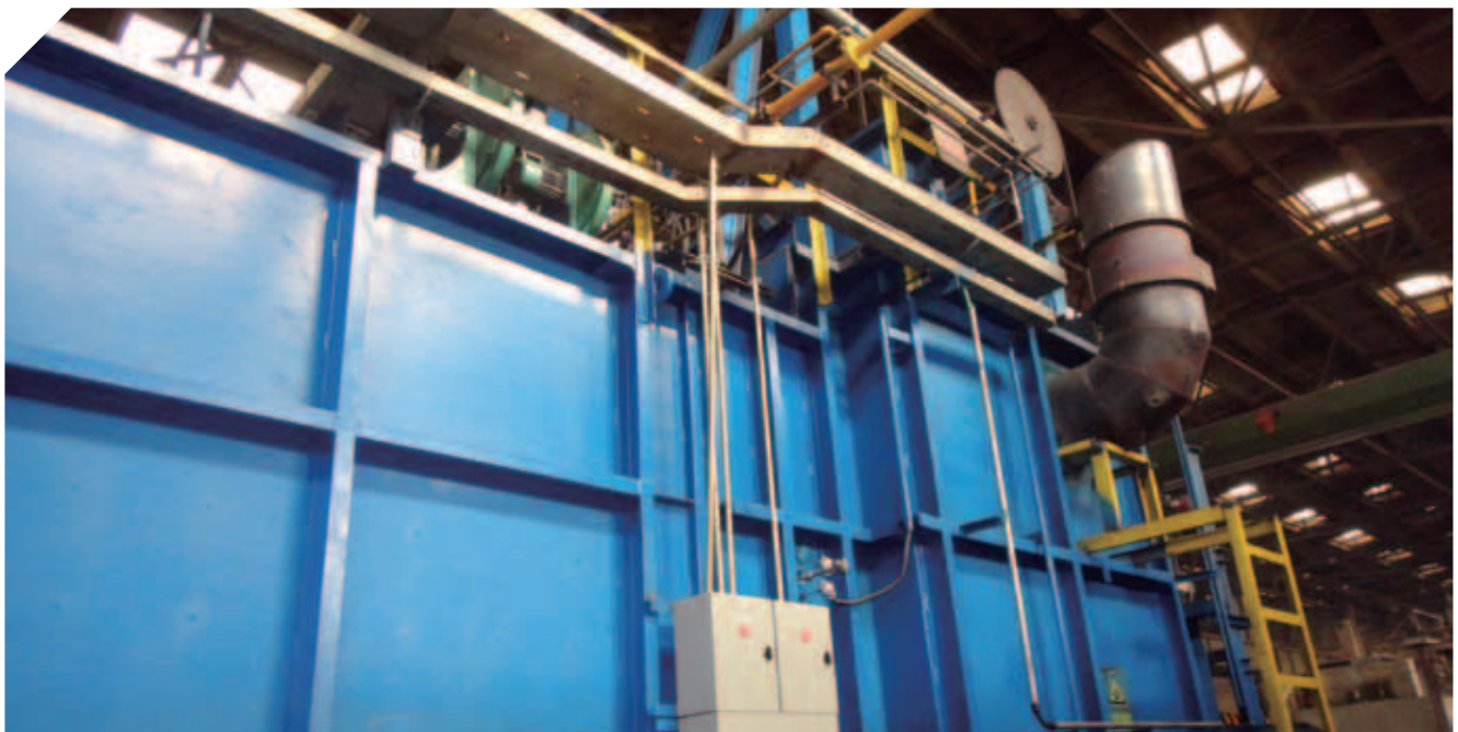
中信戴卡熱處理工序連續爐加熱區能源轉換改造項目
