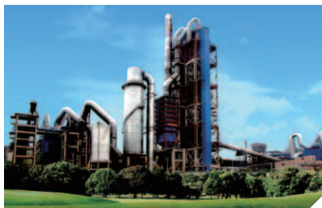
中信重工在駐馬店豫龍同力水泥有限公司建造了中國首個9兆瓦餘熱發電工程
