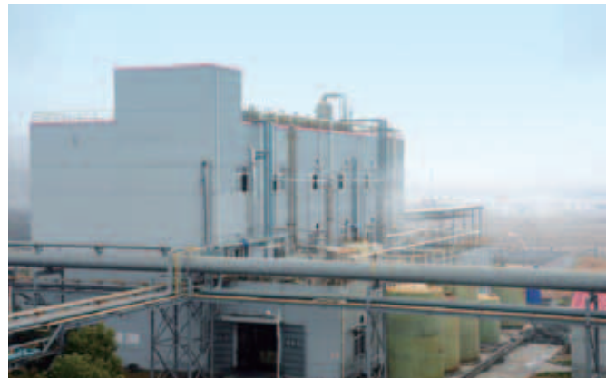
新亞星焦化廠脫硫廢液提鹽站
