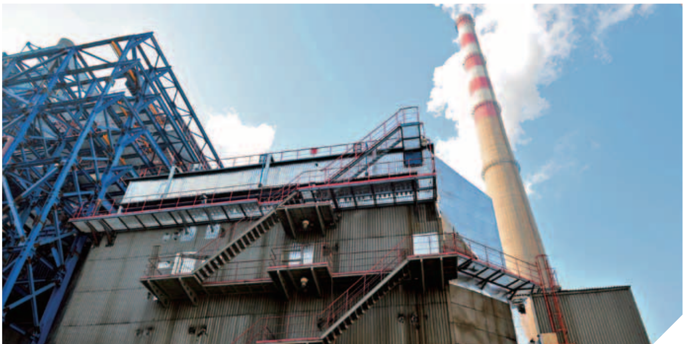
利電集團三號機組(370兆瓦)鍋爐除塵器改造完成
