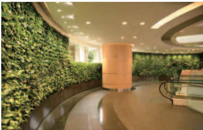
中信大廈二層垂直綠化牆約22.8m(闊)x2.2m(高)
