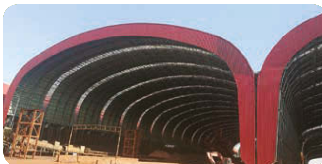
中信泰富特鋼青島特鋼原料場全封閉改造
