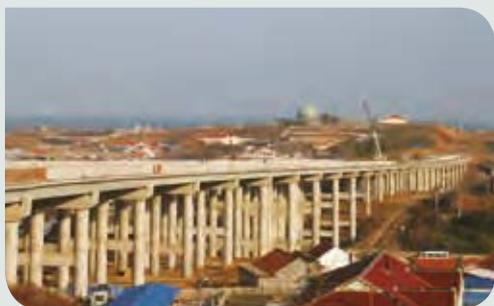
該項目是煙台市委、市政府確定實施的重大交通基礎設施項目。主路面寬25米，兩側人行道各3米，綠化帶各10米，按雙向四車道一級公路標準建設，設計速度80km/h，主線全長15公里。
