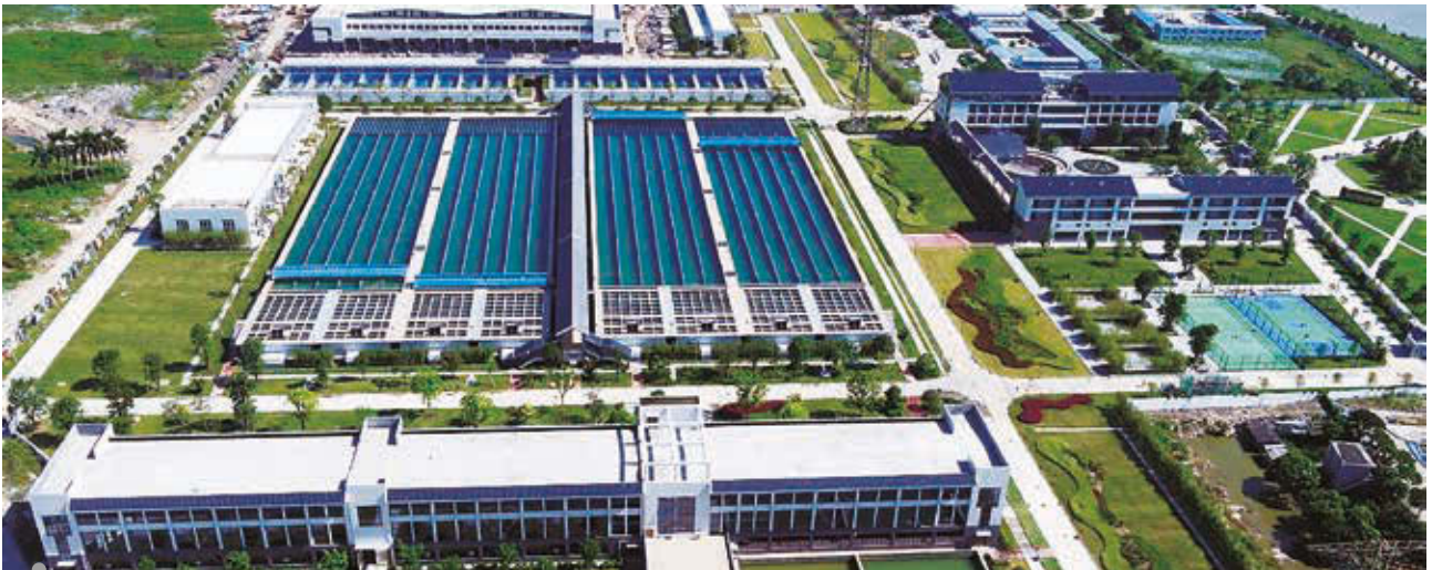
廣州北部水廠超濾膜車間
