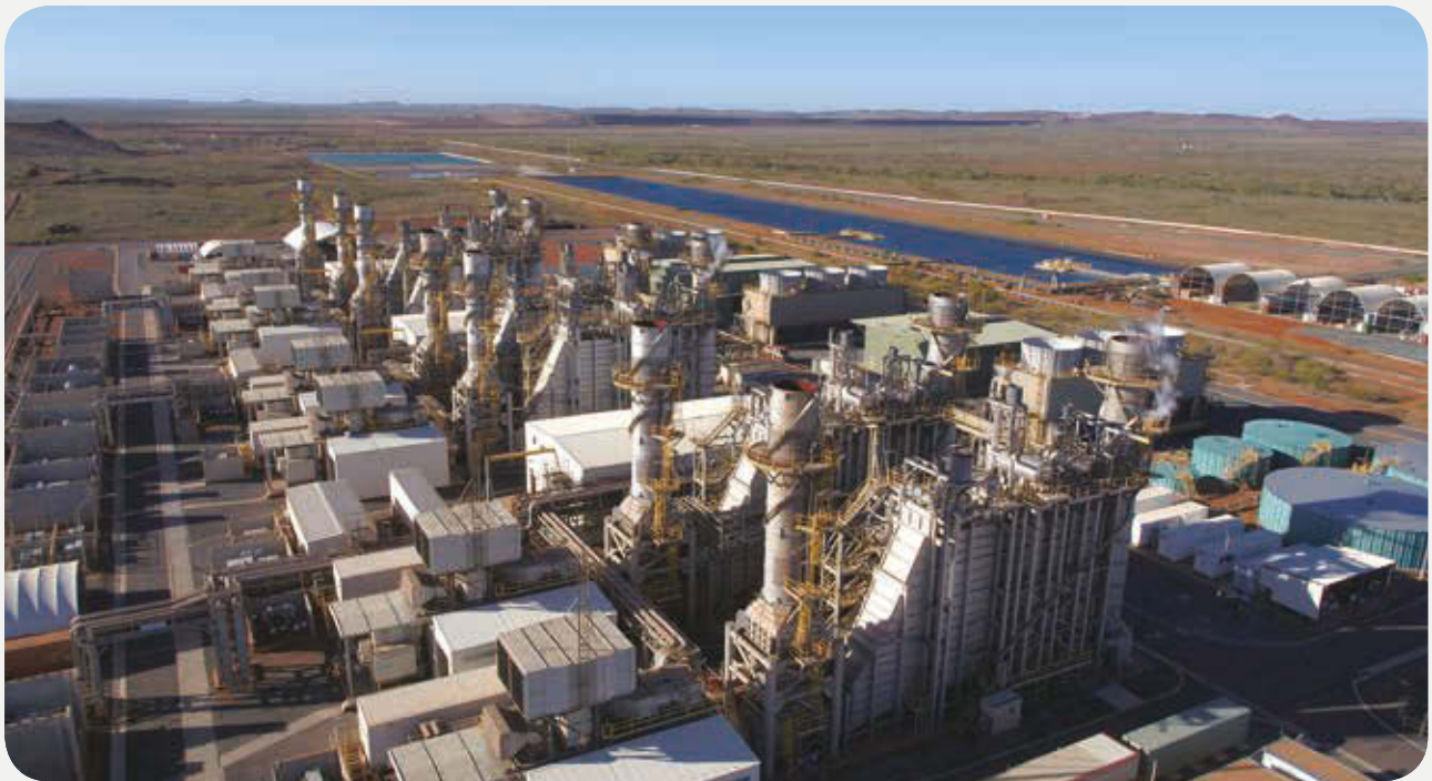
1 中信澳礦項目聯合循環燃氣發電廠
