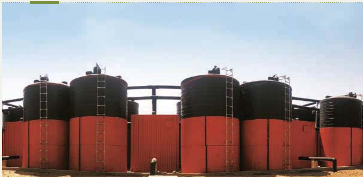
■ 中信環境技術辛集污水處理廠
