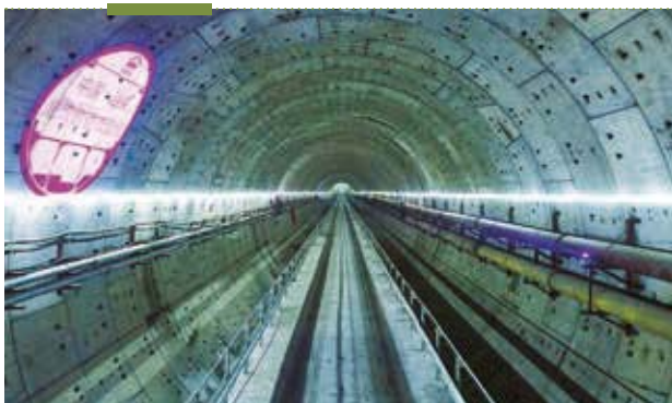
■ 中信城開汕頭海灣隧道成功實現全線貫通
