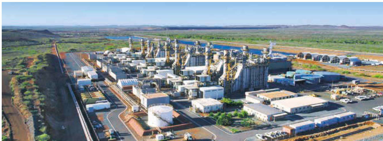
中信礦業國際高效節能燃氣聯合循環發電廠全景
