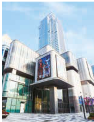
上海中信泰富廣場
