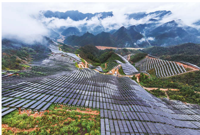
浙江桐廬農光互補光伏項目
